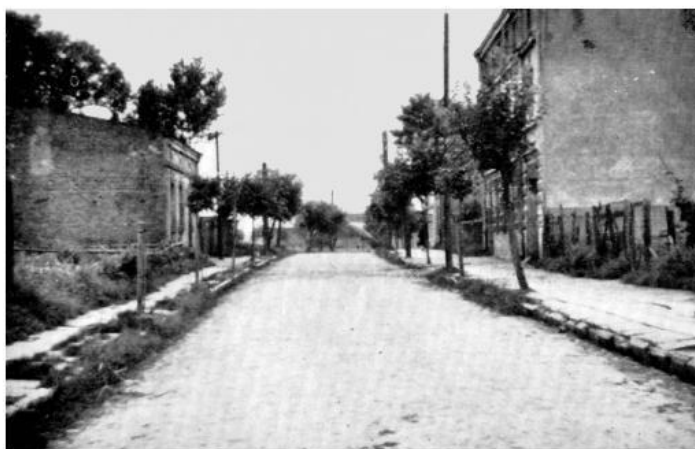
Ul. Łódzka. Związek Hafciarek i rada robotnicza były w domu po prawej stronie
